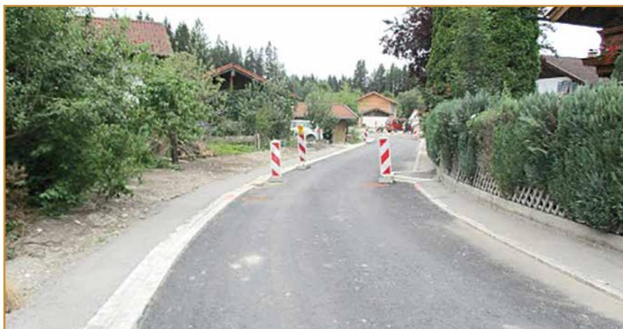
Die beiden Fotos zeigen den Tannenweg vor der Kanalbaumaßnahme und kurz nach Einbau der Tragschicht.
