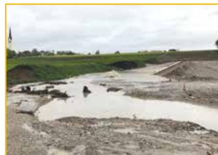
Die Wassermengen der Starkregenfälle in KW21 füllten das provisorische Übergangsbauwerk. Für kurze Zeit lief das Wasser über den Bau, da die eingebauten Rohre das Wasser nicht vollständig abführen konnten.
