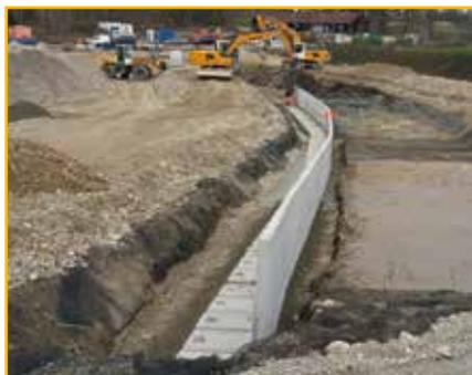
Winkelstützmauer am Dammfuß
