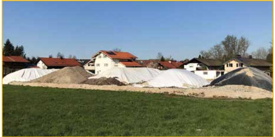
Abgedeckte Haufwerke (Aushub), bis diese abhängig vom Ergebnis der Untersuchung abtransportiert werden können
